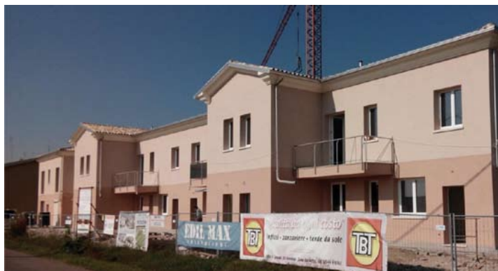
Immagine 1. Vista del cantiere delle villette a schiera.
