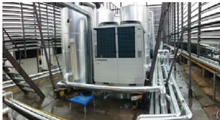
Immagine 2. Installazione sul tetto dei 4 serbatoi di accumulo termico (3x1500 litri + 1 stratificato Termal da 800 litri modello ESA800ST).
